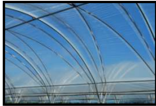
Photo 3 : Arches des tunnels
